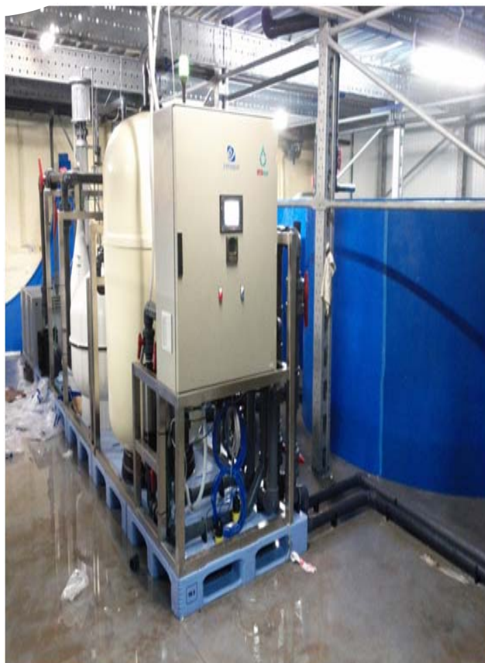
Foto 1. Proceso de instalación del Módulo IRTAmar™
